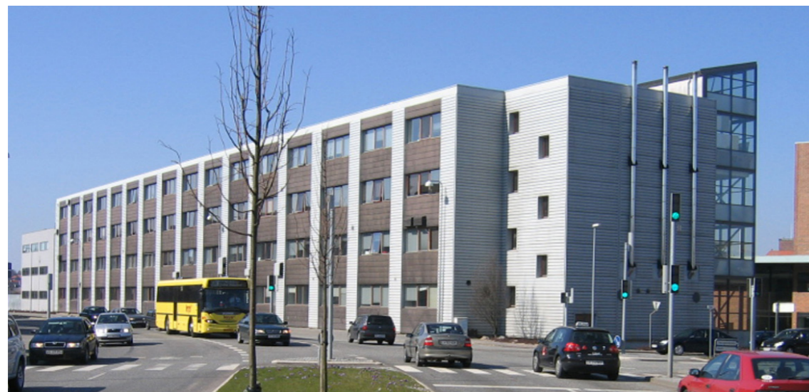
Facaden mod Sydbanegade set fra vest. 1983.
